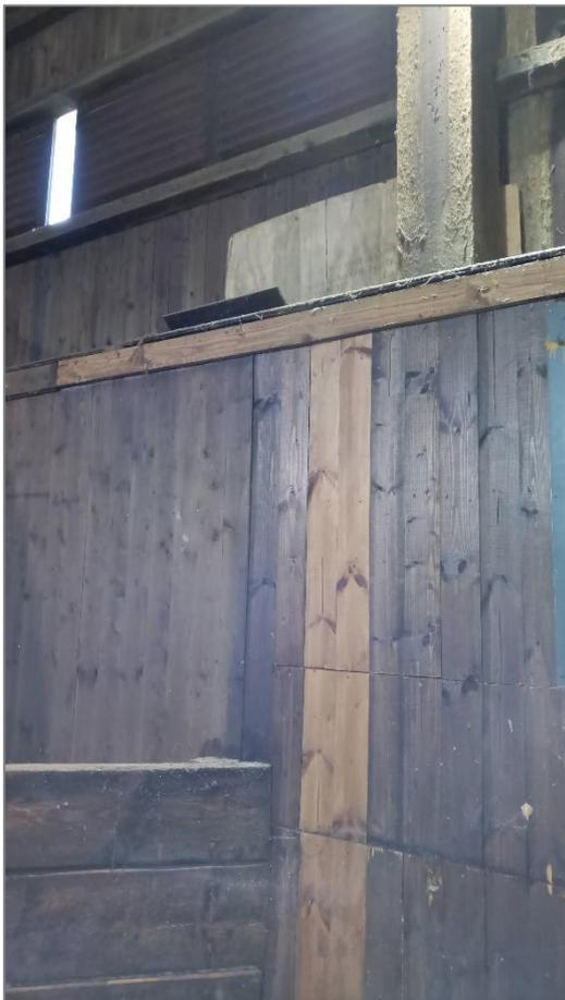
**Abbildung 3:** Holzverkleidung der Wände im Innenbereich der Halle
